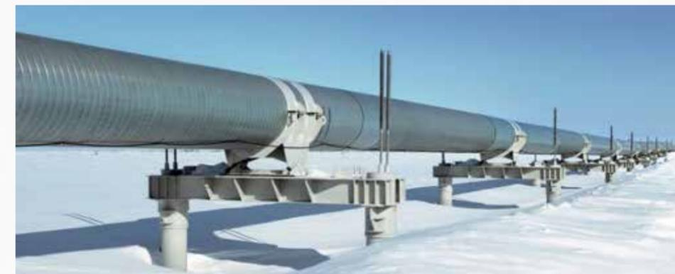
Рисунок 1.5. Опоры с термостабилизацией грунта
